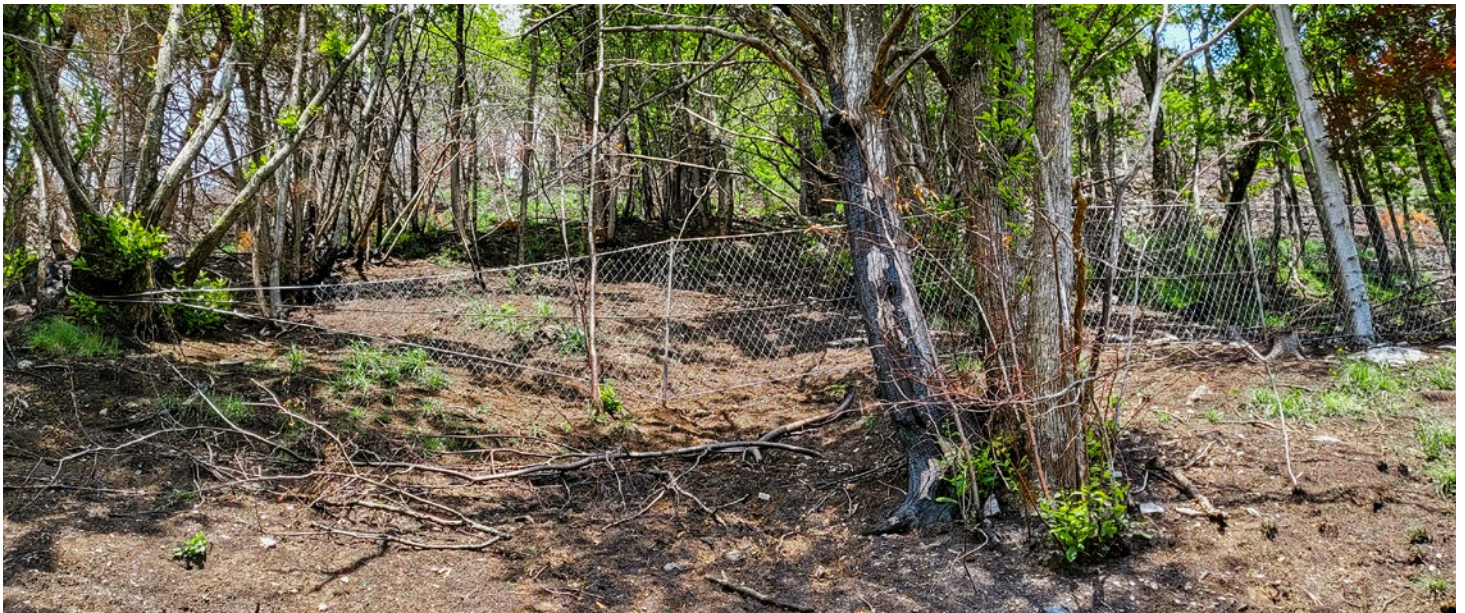
Fig. 2: Mesures urgentes pour prévenir les chutes de pierres après un incendie de Verdasio (TI) en 2022. Photo: Marco Conedera / WSL
